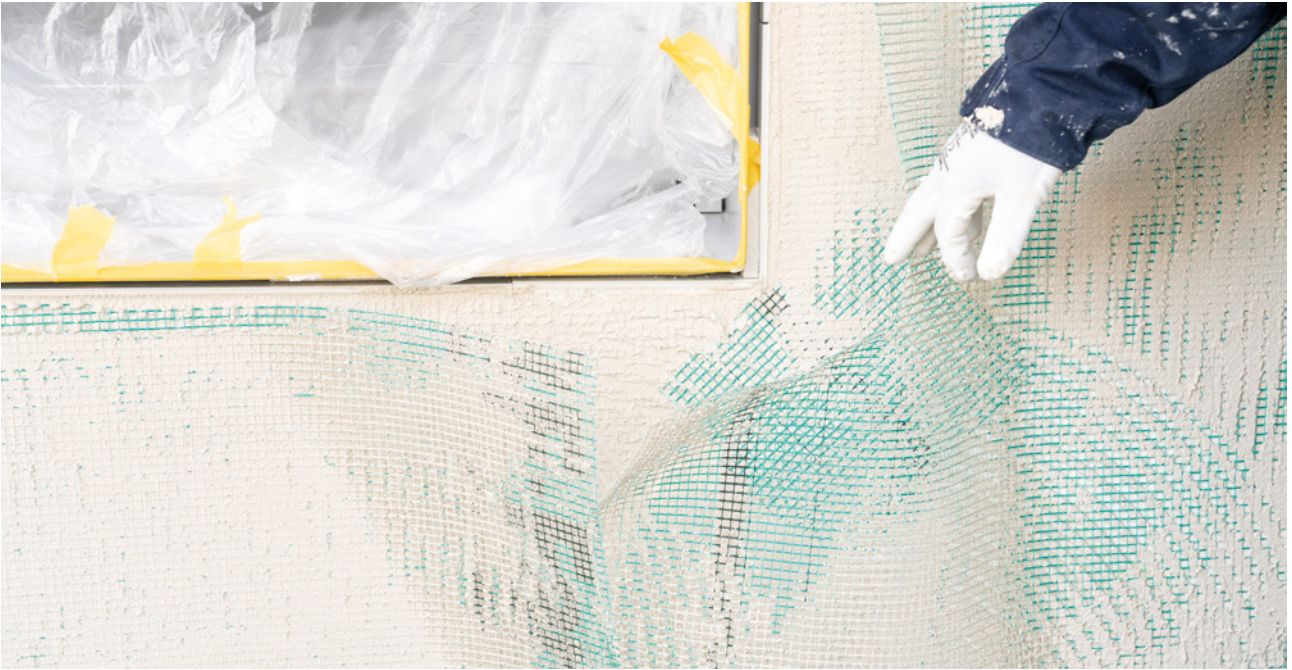
Nouvelle isolation thermique extérieure du lotissement Sternmattquartier à Lucerne.
