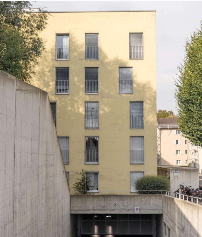
Façade avant la rénovation énergétique.
